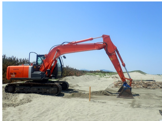
はまみどりマット施工状況②
