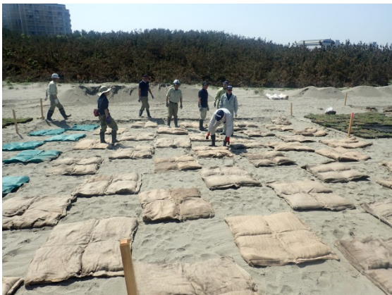
はまみどりマット施工状況①
