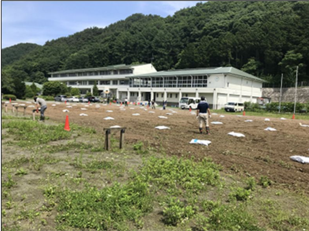
DW ファイバーの設置、散布
